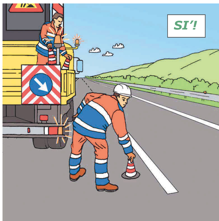
Figura 59 – Posizionamento dei coni o defleco: comportamento corretto
